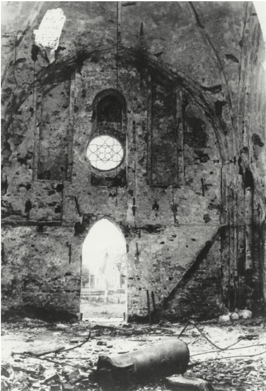
De westwand van de kerk na de brand van 1945
